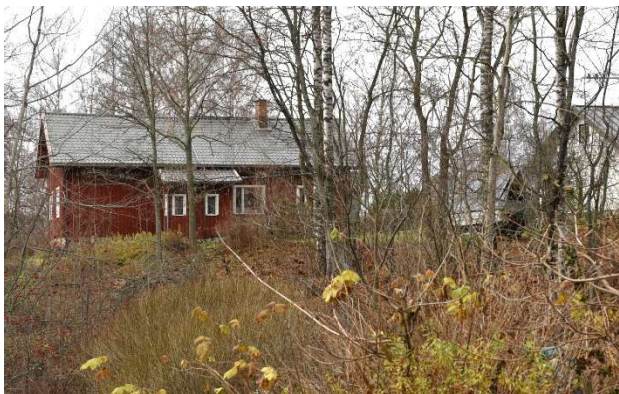
Kuva: Niementien vanhat talot on rakennettu kapealle harjanteelle, jonka itäpuolella on mäkien välinen sola.
