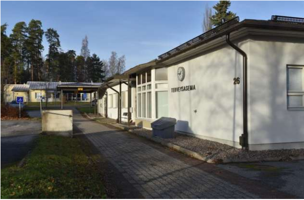
Kuva: Terveysaseman julkisivu tien suuntaan.
