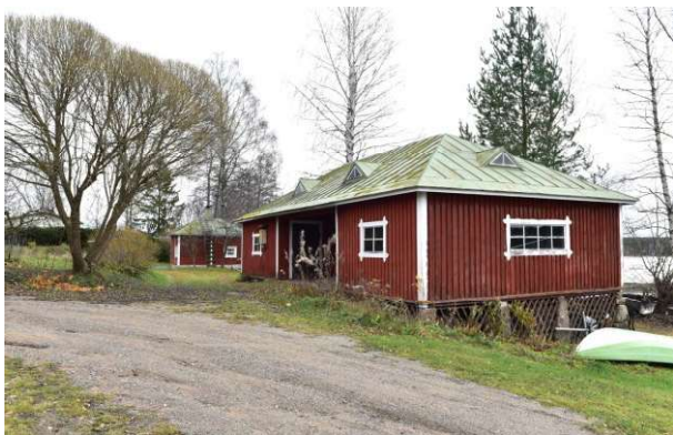
Kuva: Kaukaanrannan sauna ja makasiini.
