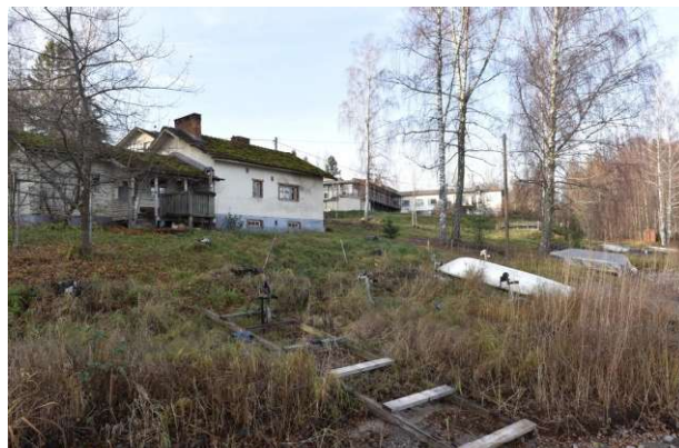
Kuva: Vanhan sairaalan alapuolella rinteessä sijaitseva pesula-sauna –rakennus on päässyt huonoon kuntoon.
